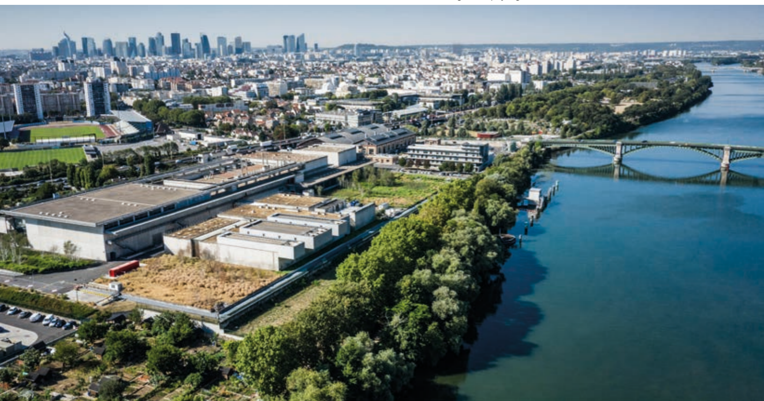
Usine Seine centre intégrée au paysage urbain
