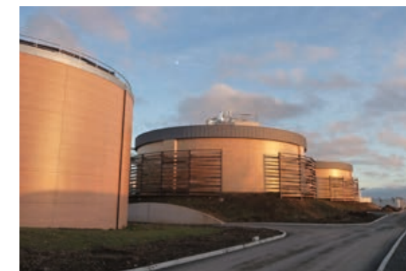
Digesteurs – Seine Grésillons
