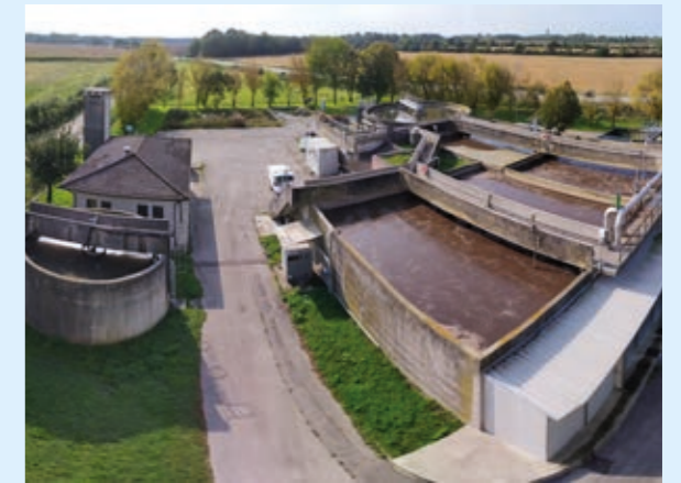
Station d'épuration équipée de traitements avancés (acide performique) - Venise
