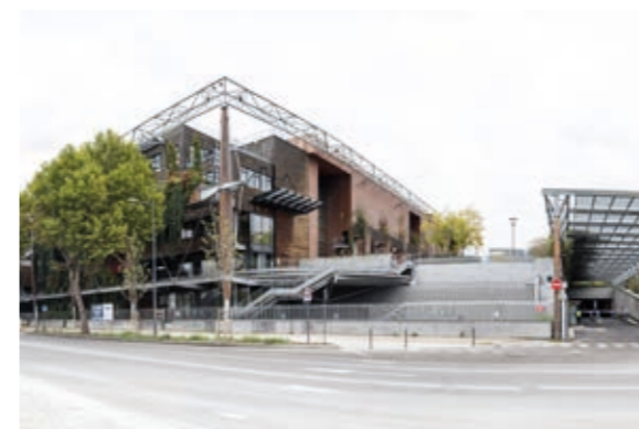
Centre d'incinération avec valorisation énergétique Isséane du Syctom - Issy-les-Moulineaux
