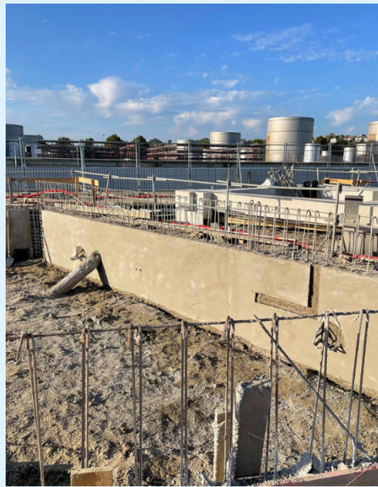
Réalisation des voiles par passe qui consolident les fondations
