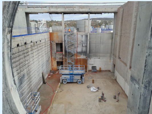
Rénovation de la zone de stockage du chlorure ferrique
